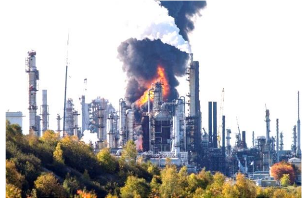
石油プラント
