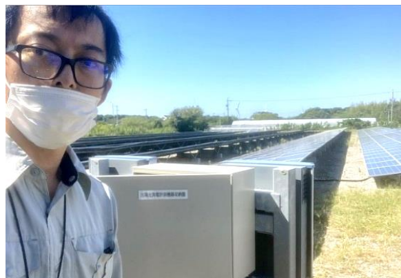
太陽光発電システムのメンテナンス
